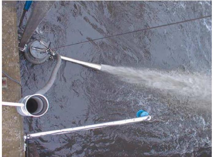
Losa limpia despues del cambio del liquido, necesitando ninguna limpieza manual. La ventilacion reduce considerablemente los olores e impide el desarrollo del sulfuro de hodrogeno (H2S). Asegura un pre-tratamiento de los residuos y reduce los riesgos de corosion del hormigon y de las tuberias de canalizacion. Ademas, se reduce el riesgo de una influencia a los procedimientos biologicos en la depuradora causada por la presencia de sulfuro de hidrogeno H2S.
