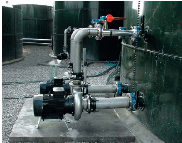
Bomba AirJet instalación en seco para un depósito de aireación en una fábrica de mermelada.
