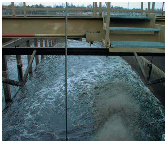
Liempieza de una balsa de tormenta.
