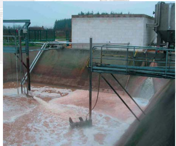
Sistema combinado con una bomba sumergida AirJet y un agitador sumergido en una balsa de una industria conservera.
